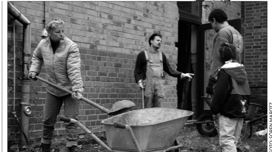
Es geht weiter, der zusätzliche Raum für die Kinder wird fertiggestellt
